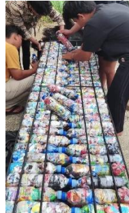
Gambar 8 Memasukkan ecobrick ke dalam kerangka Tugu Gonjong
