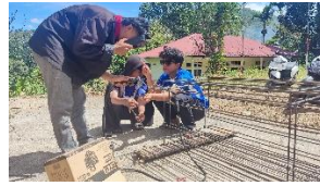
Gambar 6 Pembuatan kerangka Tugu Gonjong
