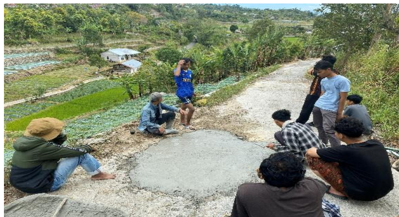
Gambar 3. Proses Penambahan Beton Pada Base Layer
