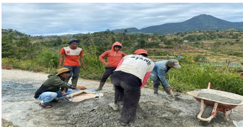
Gambar 1. Proses Pembuatan Beton Semen
