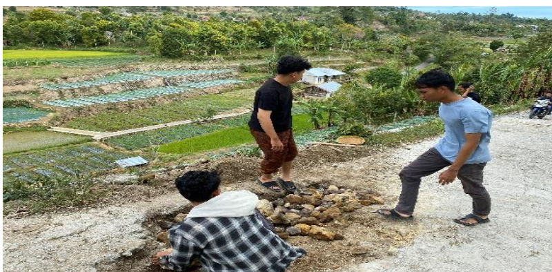
Gambar 2. Proses Pembuatan Base Layer Pada Jalan yang Rusak
