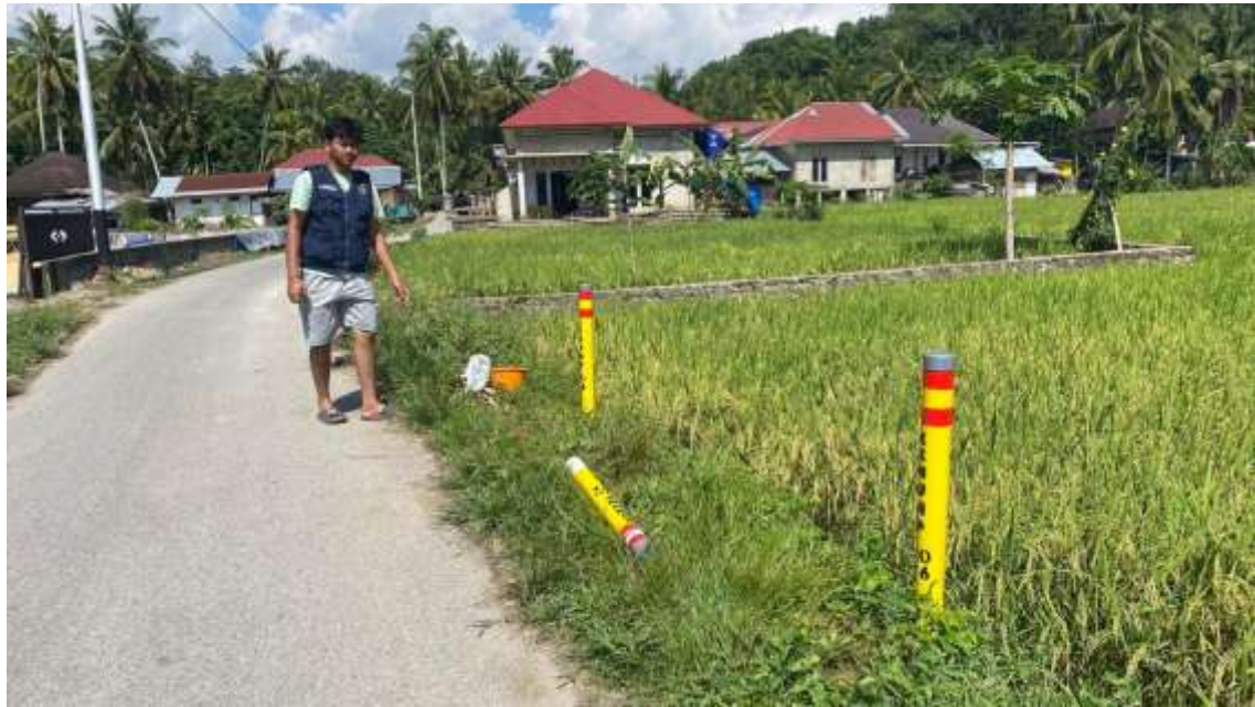
Gambar 2. Hasil Pemasangan Reflektor Paralon Pada Siang Hari
