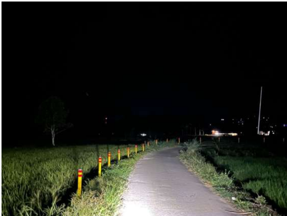
Gambar 3. Hasil Pemasangan Reflektor Paralon Pada Malam Hari
