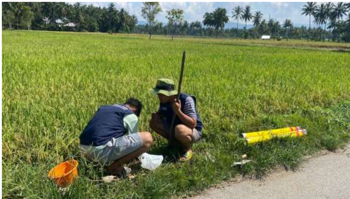
Gambar 1. Proses Penggalian untuk Reflektor Paralon
