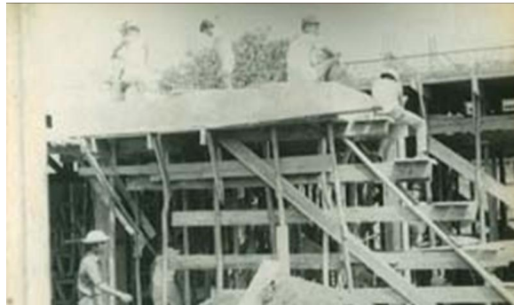
Pembangunan Gedung Gereja Katolik Paroki Kristus Salvator
