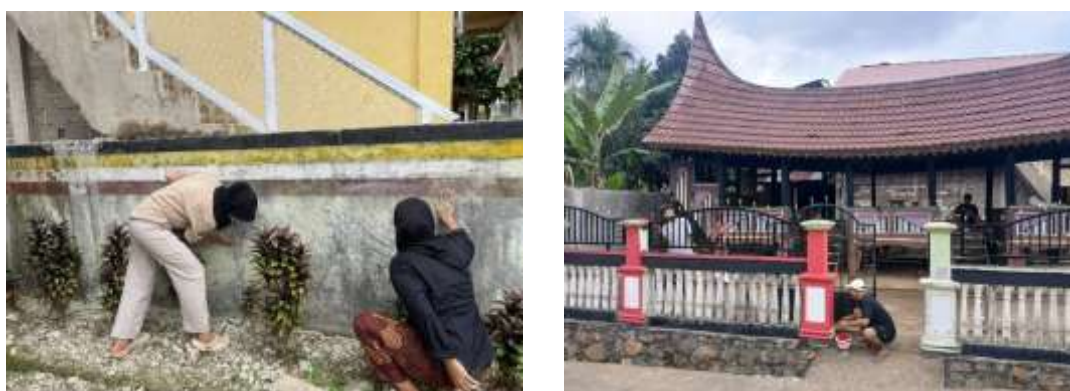
Gambar 2. Proses pembersihan dinding pagar dan pengecatan ulang
