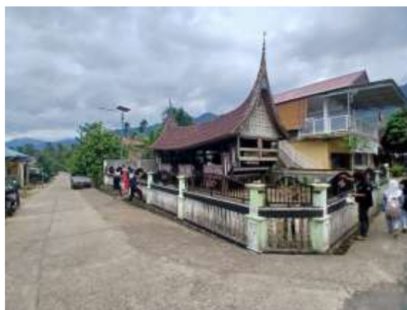
Gambar 1. Balai adat nagari Sumpur Kudus Sebelum di cat ulang
