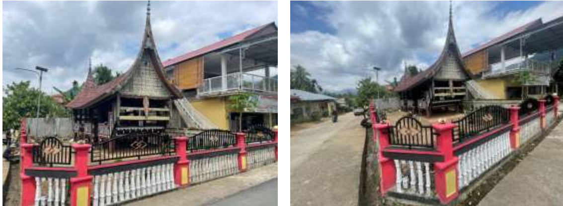
Gambar 3. Pagar Balai Adat setelah selesai pengecatan
