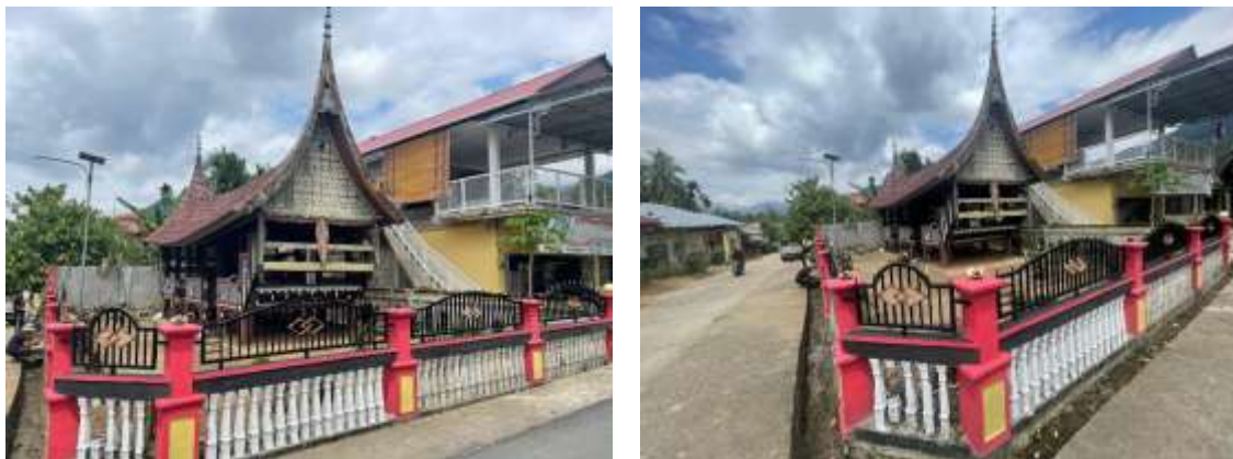
Gambar 3. Pagar Bagai Adat setelah selesai pengecatan
